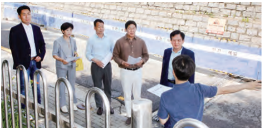
남산성곽 문화재 보수·보강 공사 현장
